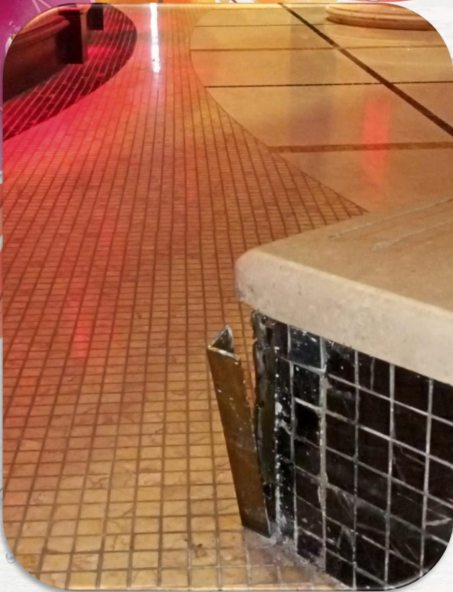
Ремонт уголка лестницы на галерею 2-го этажа
