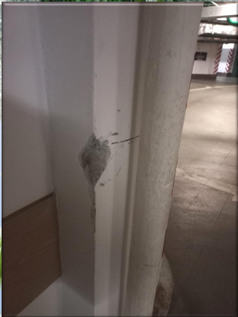
Восстановление угла колонны
