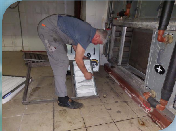
Замена фильтра установки приточной вентиляции
