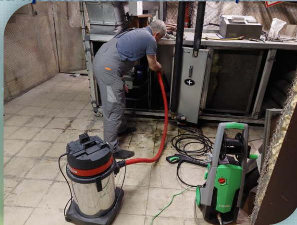
Чистка установки приточной вентиляции
