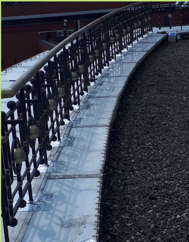
Герметизация козырьков кровли
