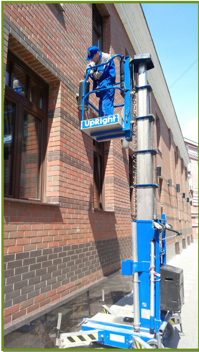
Ремонт наружного освещения
