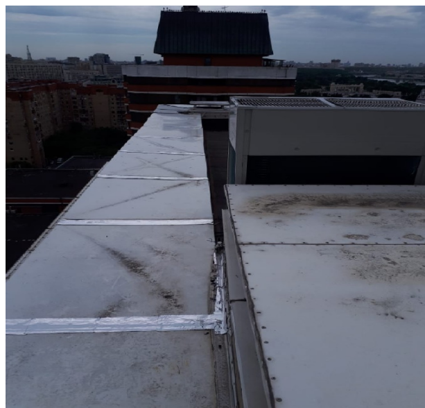
Герметизация козырьков кровли
