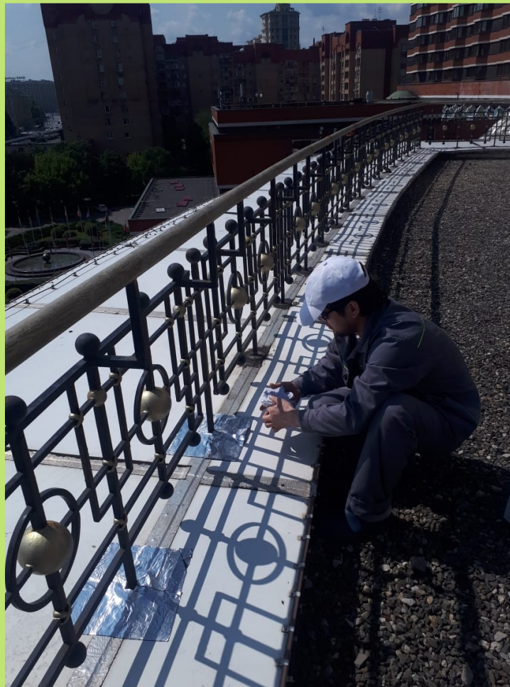
Герметизация козырьков кровли
