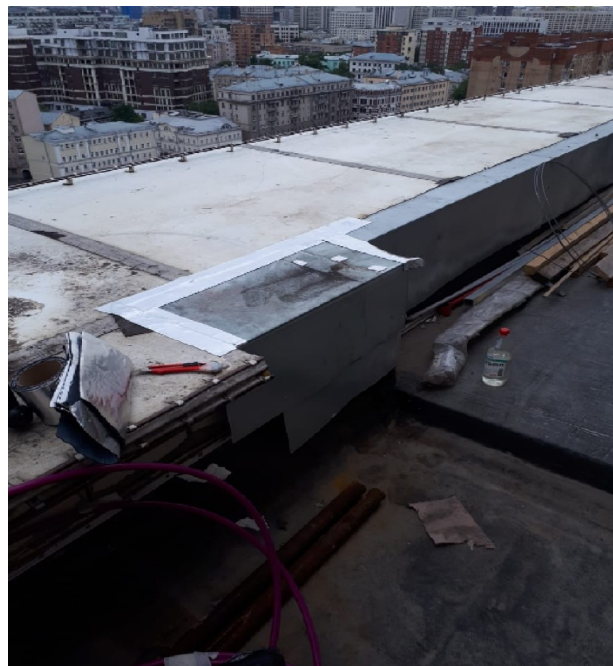
Герметизация козырьков кровли
