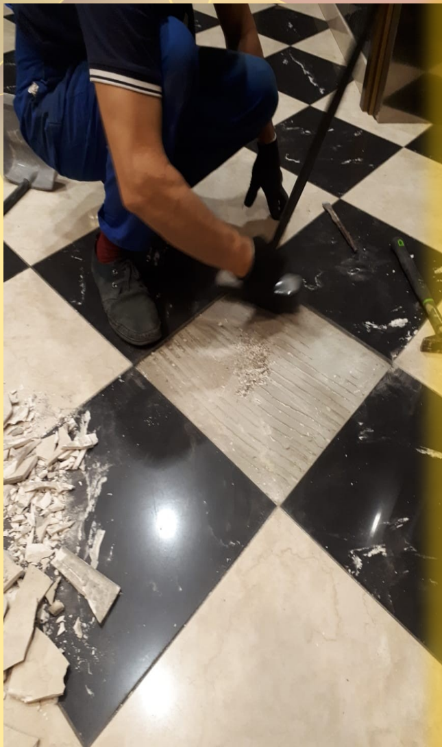
Ремонт плитки 1-я секция 1-й этаж
