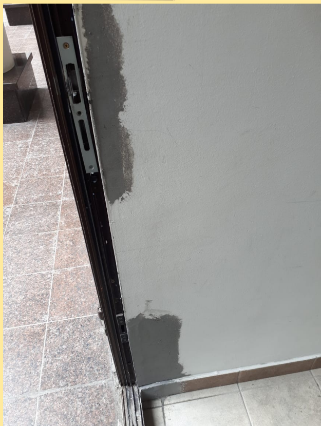
Покраска стен 5 секция выход во внутренний двор
