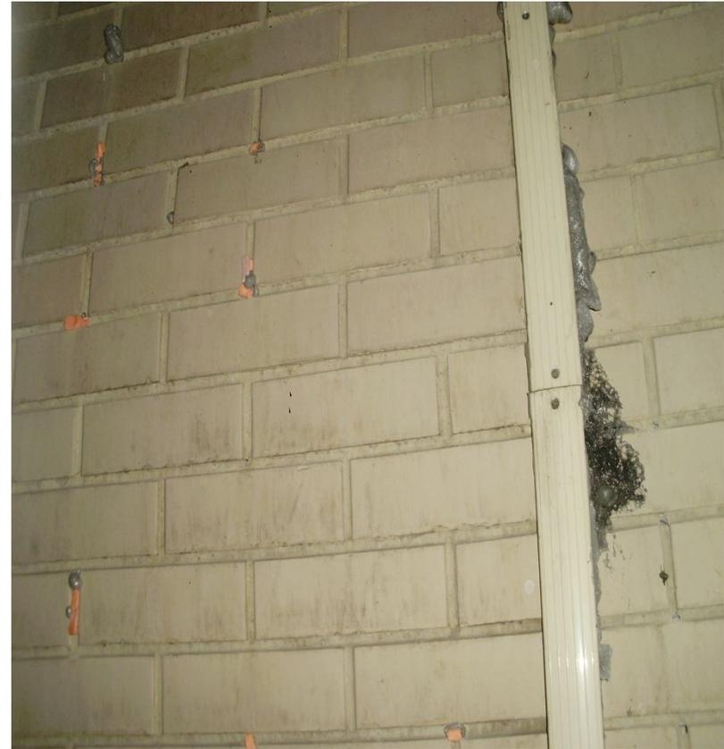
1. Выявленный участок (пузырь) отслоившейся плитки на фасаде 3 секции.
