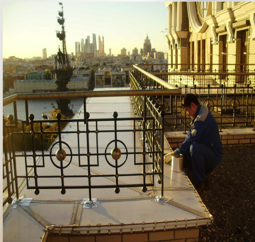
*- ремонт черепичного покрытия карниза 2 этажа 5-ой и 6-ой секций (внутренний дворик) с герметизацией кровли карниза,*
