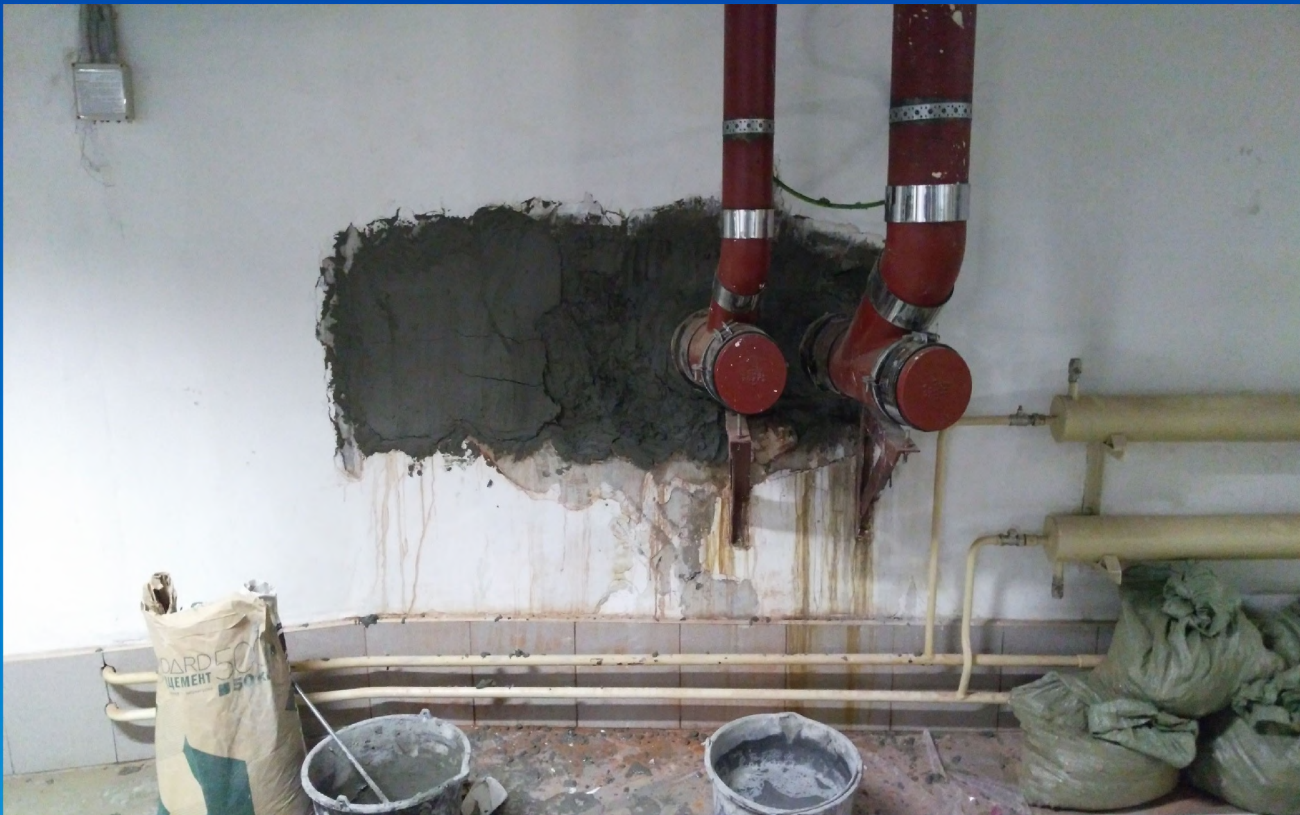
Ремонт гидроизоляции выхода канализационных труб на паркинге -2 уровня.
