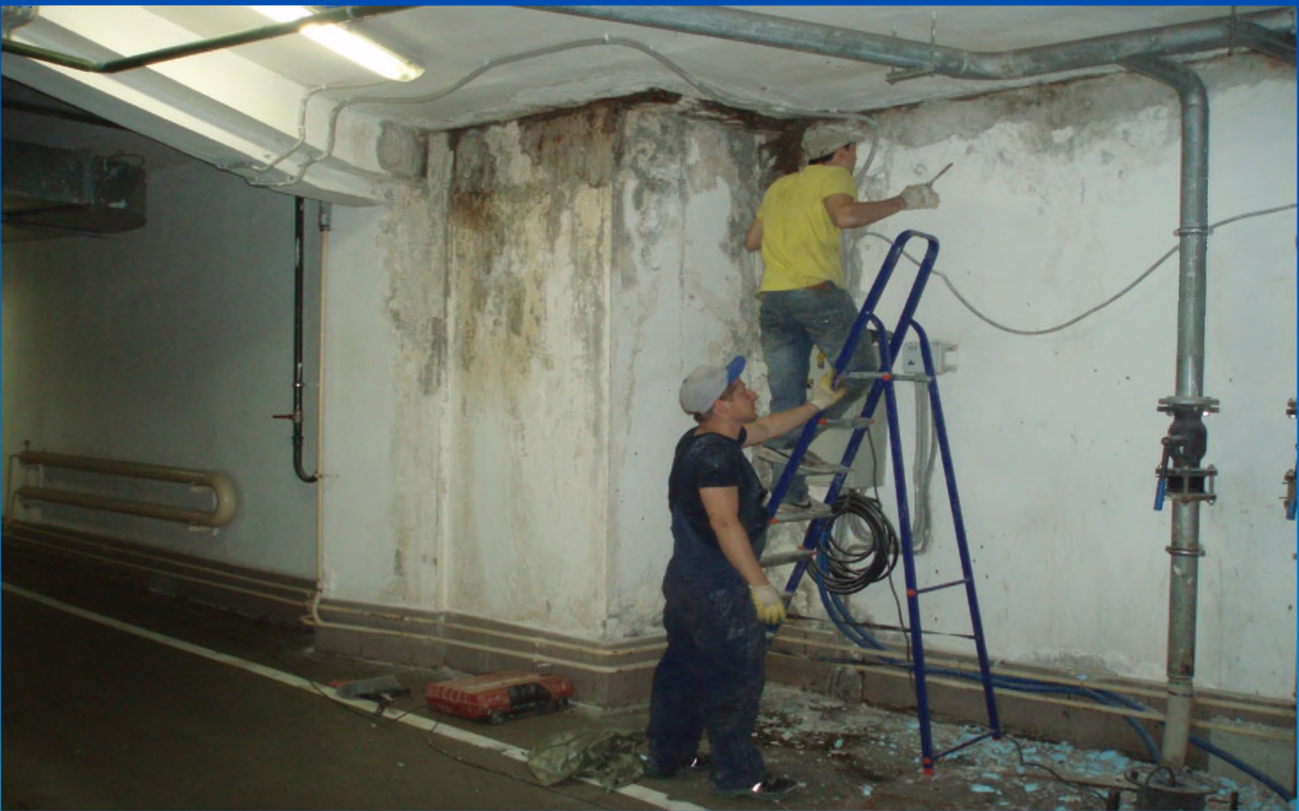
Ремонт гидроизоляции протекающей стены паркинга -2 уровня
