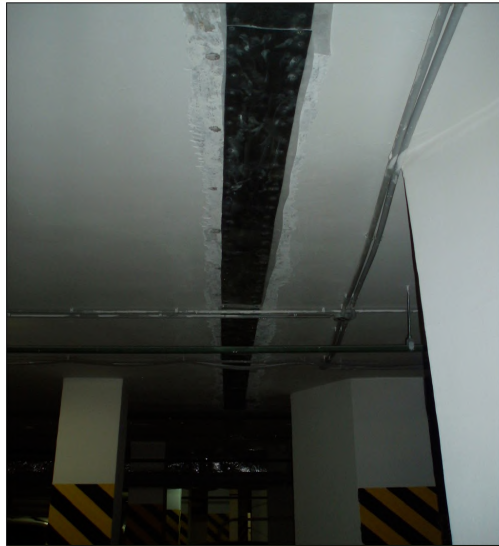
Гидроизолированный участок перекрытия паркинга -1 уровня
