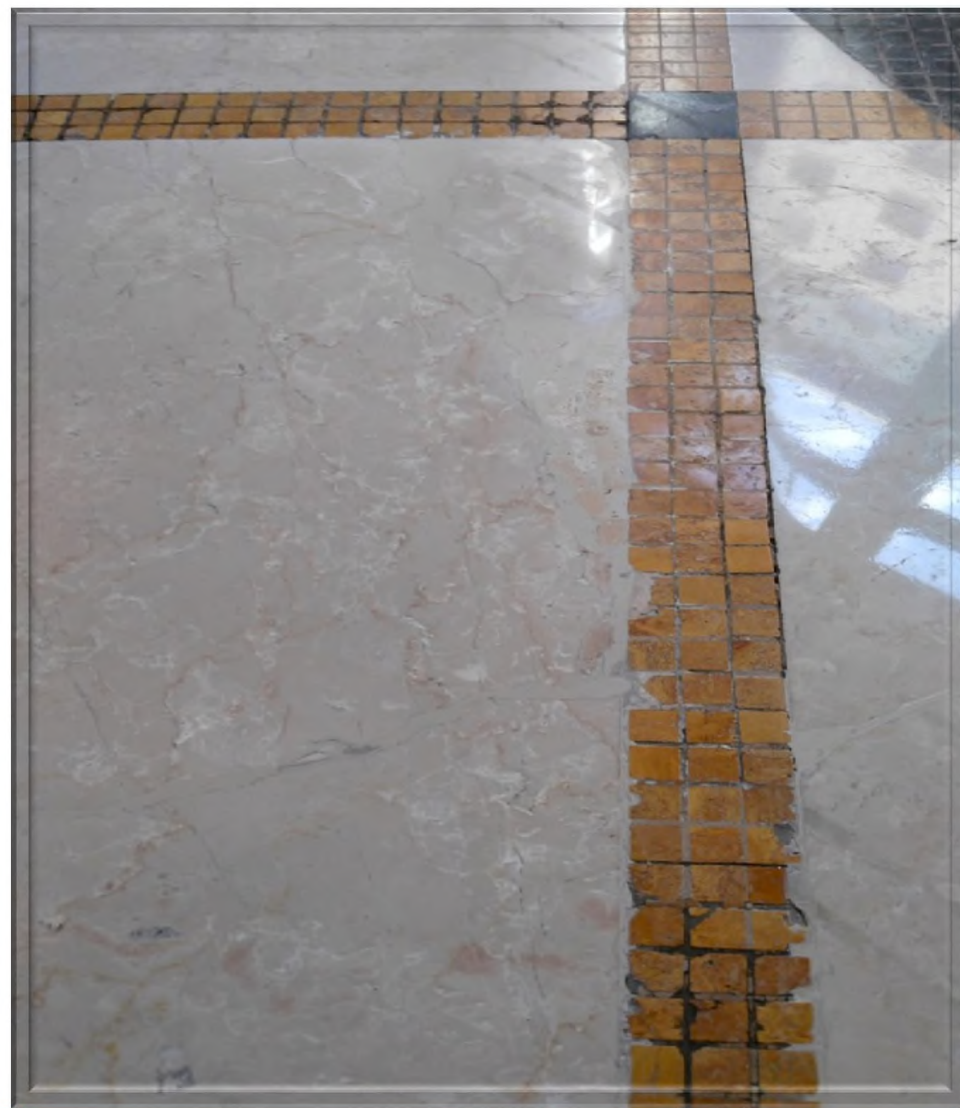
Трещина после ремонта
