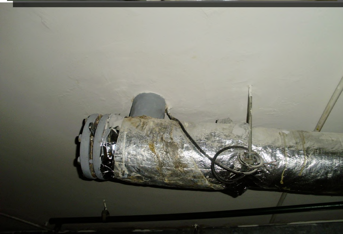
Ввод труб-после гидроизоляции.
