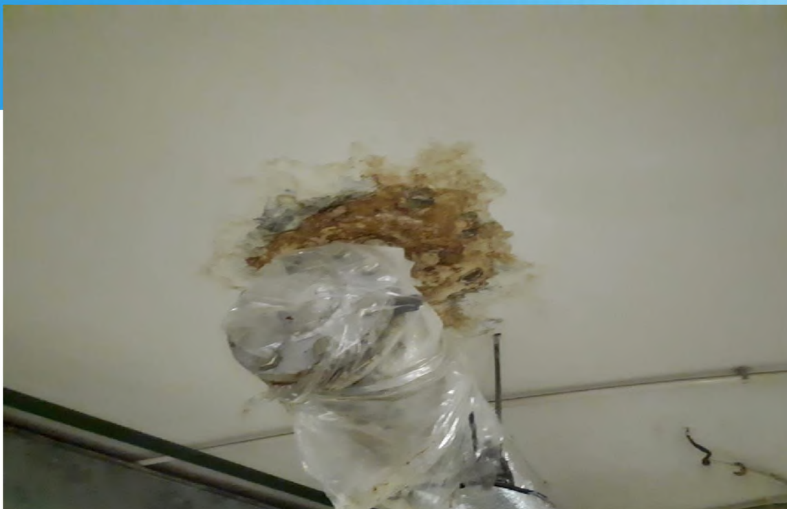
Ввод трубы - до гидроизоляции
